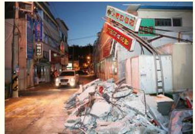
• 흥해읍 상가 외벽 붕괴
